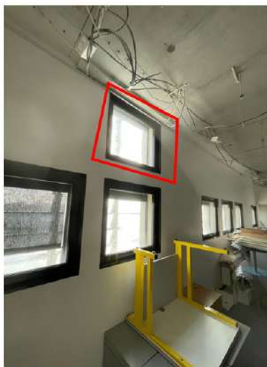
Figure 5 - Châssis impactés par les passages de gaine
