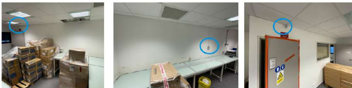
Figure 12 - Implantation de la détection gaz existante à déplacer/déposer
