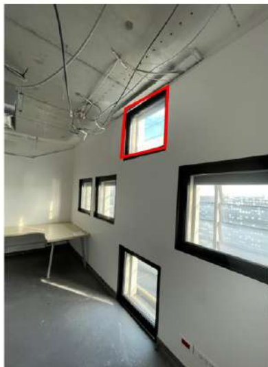
Figure 5 - Châssis impactés par les passages de gaine
