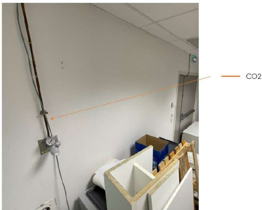
Figure 8 - Point de distribution en salle E2.11
