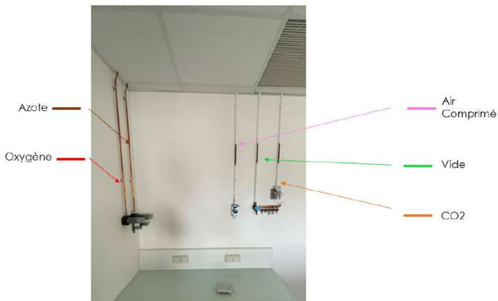
Figure 9 - Point de distribution existant en salle C1.11
