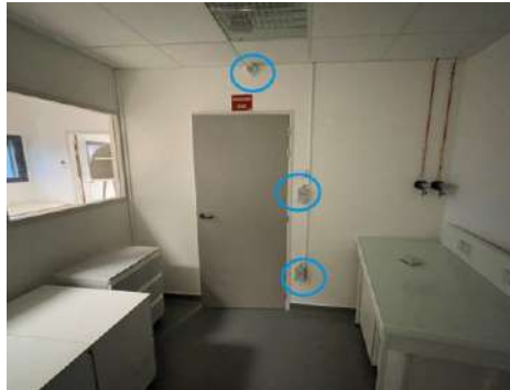
Figure 13 - implantation de la détection en salle C1.11 existante à déplacer
